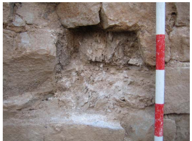
FOTO 44. Un dels possibles impactes de bala de canó en el parament de la torre oriental de la muralla
