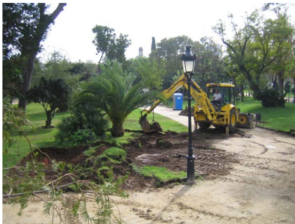
FOTO 3. Inici del rebaix dels parterres
