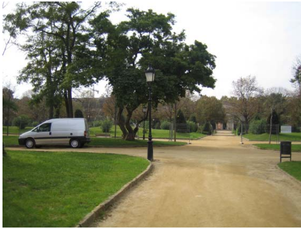
FOTO 1. Estat de l'àrea intervinguda abans de començar els treballs
