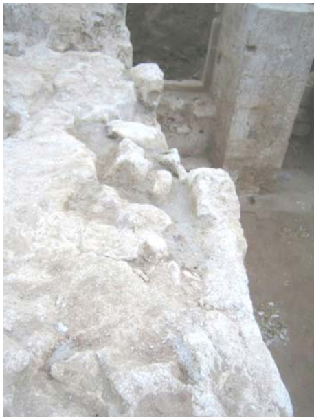
FOTO 82. Consolidació amb morter de calç
