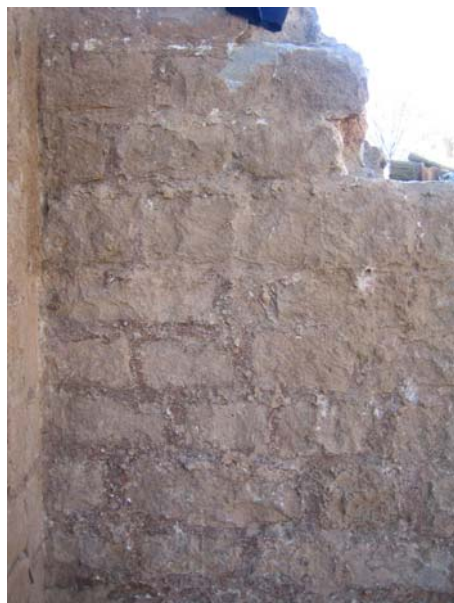
FOTO 78. Una altra imatge on podem observar el morter acolorit del rejunt dels carreus
