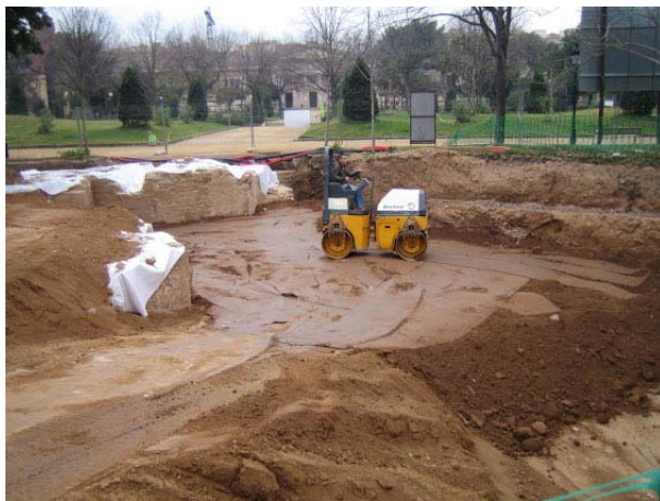
FOTO 66. Compactació de la terra aportada per tal de reblir l'àrea d'excavació
