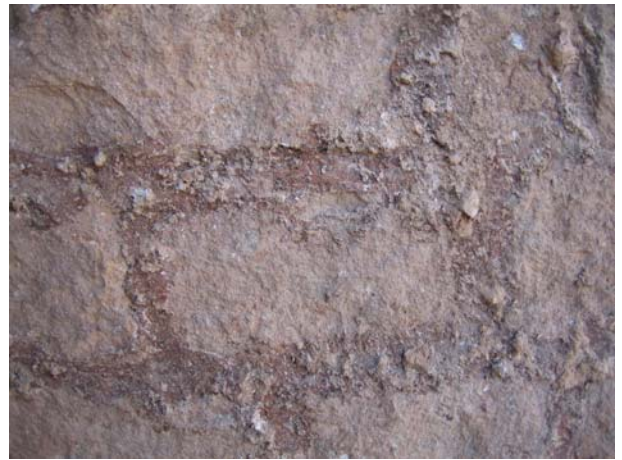
FOTO 77. Morter acolorit del rejunt dels carreus
