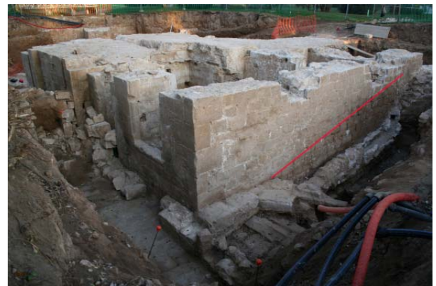
FOTO 40. Línia hipotètica que marca l'encintat de morter del mur UE 125 i que molt possiblement està indicant l'existència en aquest punt d'una rampa per pujar al terraplè de la muralla
