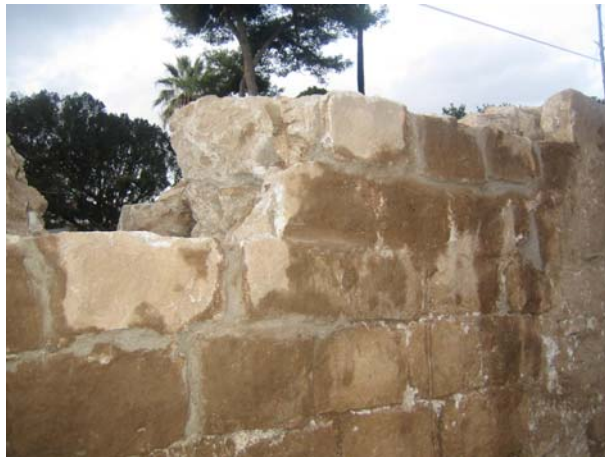
FOTO 74. Recol·locació dels carreus mur
