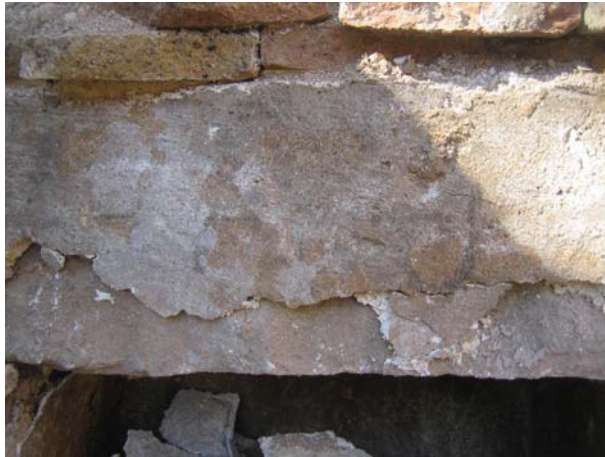
FOTO 80. Una altra presa on podem observar les restes de pintura decorativa al voltant de la fornícula de l'edifici adossat a la muralla
