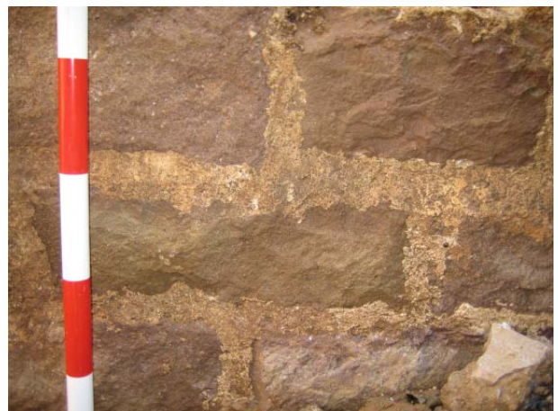
FOTO 32. Detall de l'encintat exterior de la barana del pont de Sant Daniel, obra que segons la documentació data de finals del segle XIV
