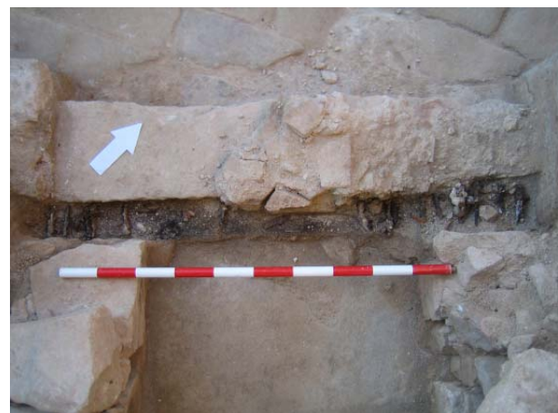
FOTO 12. Detall de les restes del muntant de fusta que allotjava una porta per al passadís que estrenyia el pas pel portal. Podem apreciar-hi alguns claus in situ
