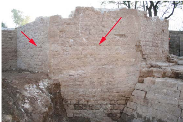
FOTO 56. Vista de la torre oriental del Portal de Sant Daniel on podem apreciar-hi la línia horitzontal del parament (fletxes vermelles) que podria correspondre a una aturada dels treballs de construcció.
