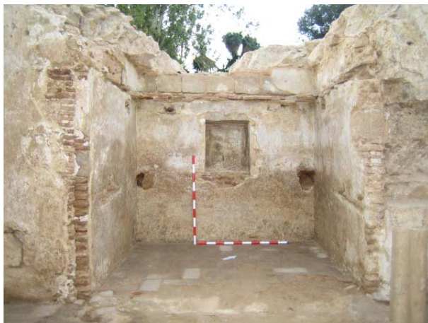
FOTO 23. Àmbit C de l'edifici annex a la muralla. Aquest espai va ser guanyat a la muralla buidant-ne part del seu farciment
