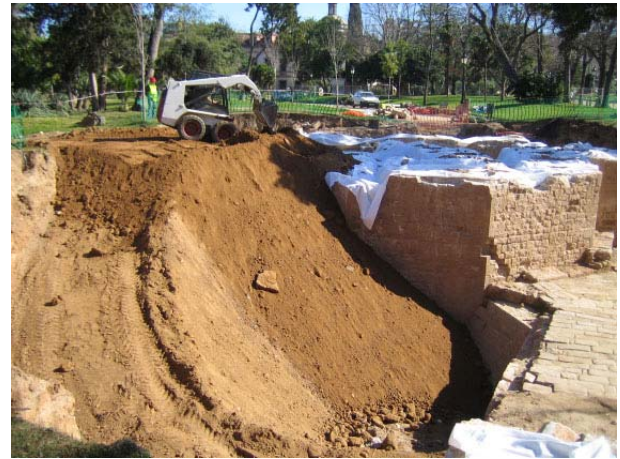
FOTO 65. Treballs de rebliment del jaciment
