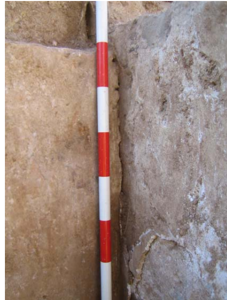
FOTO 22. Detall on podem apreciar com el mur que separa els àmbits A i B de l'edifici adossat a la muralla (UE 223) s'adossa a l'arrebossat anterior de la muralla medieval (UE 142)
