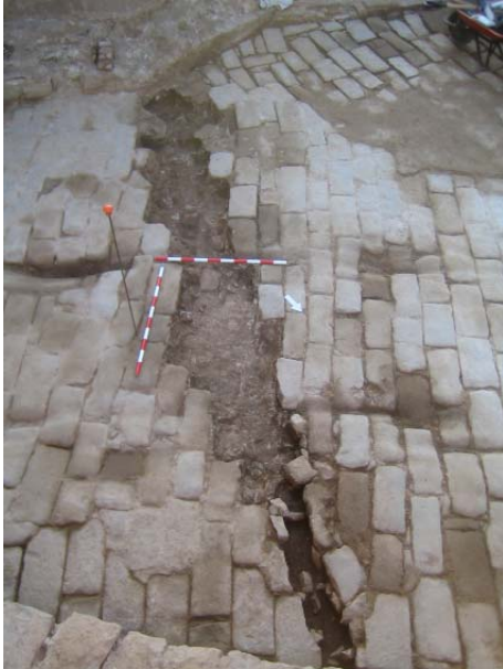
FOTO 29. Rasa, molt possiblement relacionada amb algun element defensiu, ara desaparegut, que se situa en el pont, a tocar del Portal de Sant Daniel
