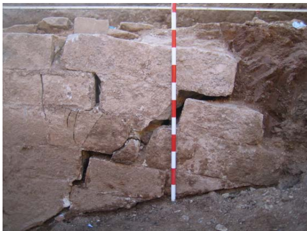
FOTO 35. Punt on el pont va ésser escapçat per tal de construir el baluard "Del Rey" de la Ciutadella
