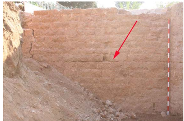
FOTO 54. Tram de la muralla medieval al nord del Portal de Sant Daniel. Podem observar-hi una línia horitzontal al parament (fletxa vermella) que pot correspondre a una aturada dels treballs de construcció de la muralla i, a l'esquerra, una esquerra que possiblement està relacionada amb les bretxes que es van produir en aquest sector durant el setge de 1714
