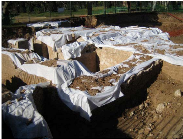
FOTO 64. Protecció / senyalització de la part superior de les restes abans del seu rebliment
