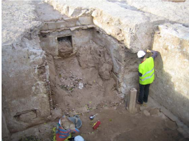
FOTO 45. Consolidació d'arrebossats per part del personal de restauració
