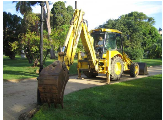
FOTO 2. Inici dels treballs amb la màquina retroexcavadora mixta
