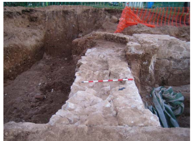
FOTO 36. Imatge on podem apreciar com el mur UE 294 (a l'esquerra), reforça el mur UE 251, molt possiblement per enfortir el paper de mur de contenció que prenen aquestes estructures quan es basteix el terraplè de la muralla en aquest sector, a principis del segle XVII
