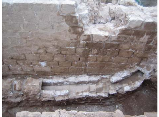
FOTO 73. Foto final amb recol·locació dels carreus d'un mur i una claveguera
