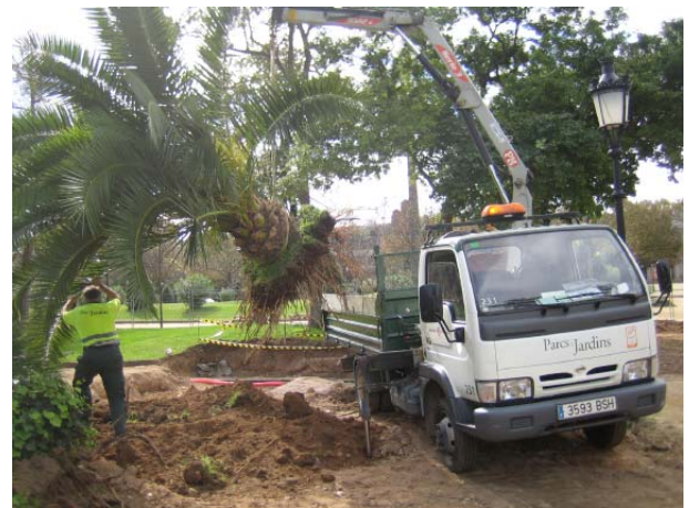
FOTO 4. Trasllet d'una planta situada dins de l'àrea d'excavació
