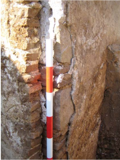
FOTO 25. Detall del mur de maons i carreus (UE 143) que revesteix la cavitat efectuada al farciment de la muralla (UE 162) per tal de construir l'àmbit C de l'edifici que s'adossa a l'estructura murària
